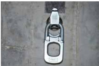
Der HALFEN Bergungsanker besteht aus einem einbetonierten Edelstahl-Kugelkopfanker der Lastklasse 20,0, an den eine frei drehbare Kupplung angehängt wird, welche normalerweise für den Transport von Betonfertigteilen eingesetzt wird.
