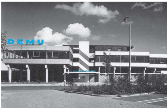
DEMU Herstellwerk in Utrecht
