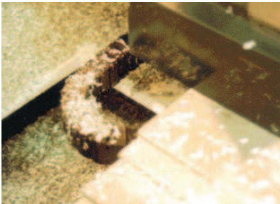
E2 E-Rohre seitlich freitragend im Spänebereich eingebaut
